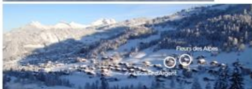
Vue de la vallée des Aravis et situation des chalets
